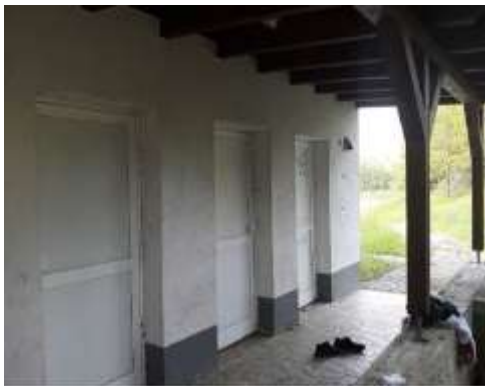
Bild 5: Zugang Toiletten + Technikraum
